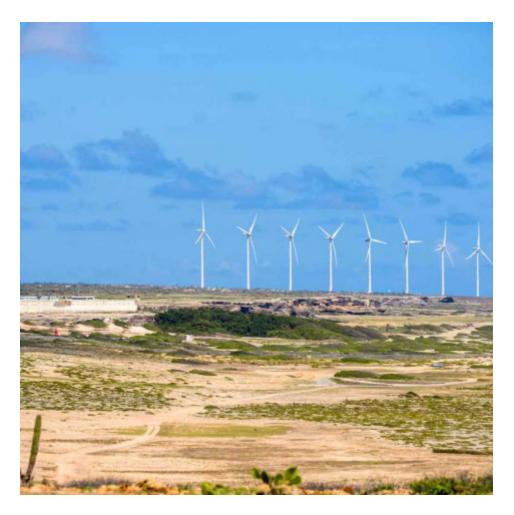
SDG 7 · Bezahlbare und Saubere Energie Der Windpark deckt bis zu 15 Prozent des Strombedarfs in Aruba und stärkt somit die Selbstversorgung und Energiesicherheit des Inselstaats.
